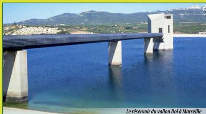
Le réservoir du vallon Dol à Marseille
